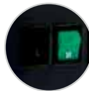
Interrupteurs / Switches on/off & Ventilation
