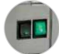
Interrupteurs / Switches on/off & Ventilation
